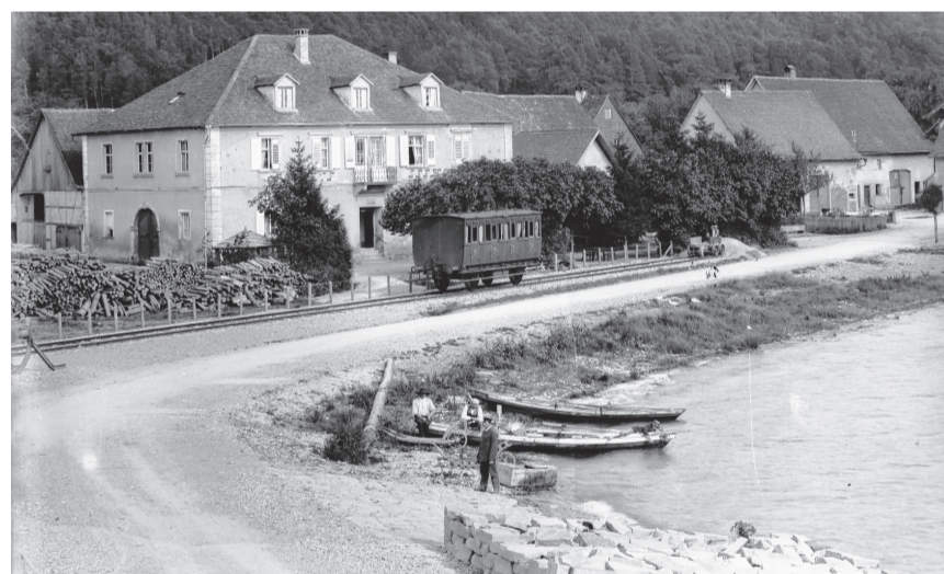
Hier steht im Juli 1902 ein Abteilwagen der I. und II. Klasse der Großherzoglich Badischen Staatseisenbahn, gebaut zwischen 1862 und 1874, vor der ehemaligen Unteruhldinger Gred. Das Gleis endet mit einem Prellbock, von hier aus sollten die Züge weiter nach Meersburg fahren. FOTO: SAMMLUNG METZ IM HAUS DER GESCHICHTE BADEN-WÜRTTEMBERG
