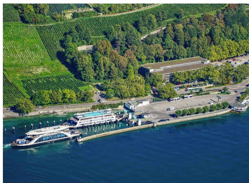
Der Meersburger Bahnhof wäre in etwa dort gebaut worden, wo heute das neue Parkhaus an der Fähre steht. Die Gleise sollten von Unteruhldingen her direkt am Seeufer entlang geführt werden. ARCHIVFOTO: GERHARD PLESSING
